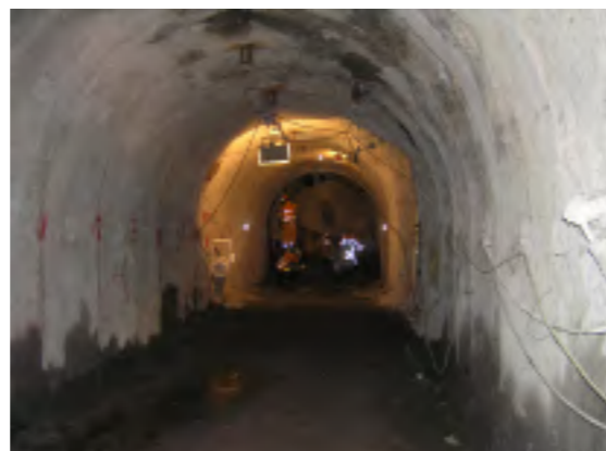
水平坑道の貫通後の様子（主立坑側から撮影）
